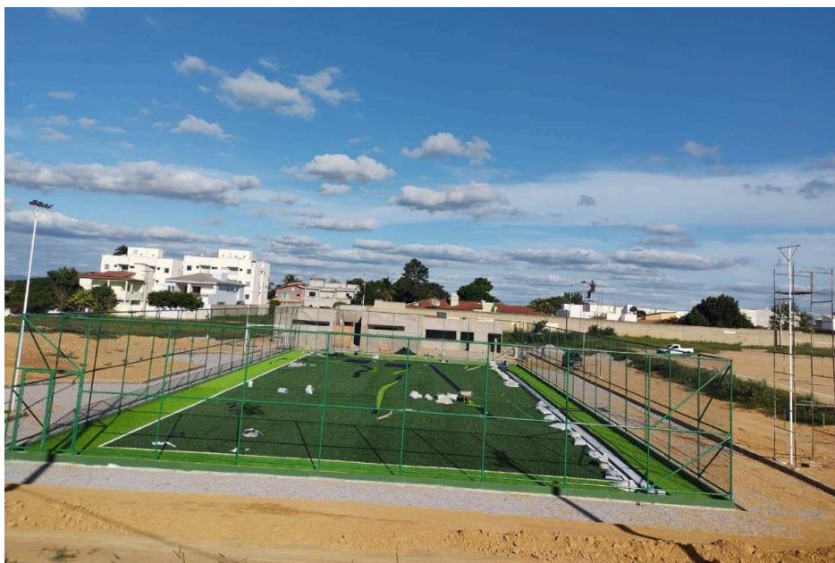
Figura 15: Espalhamento de borracha de grama sintética
