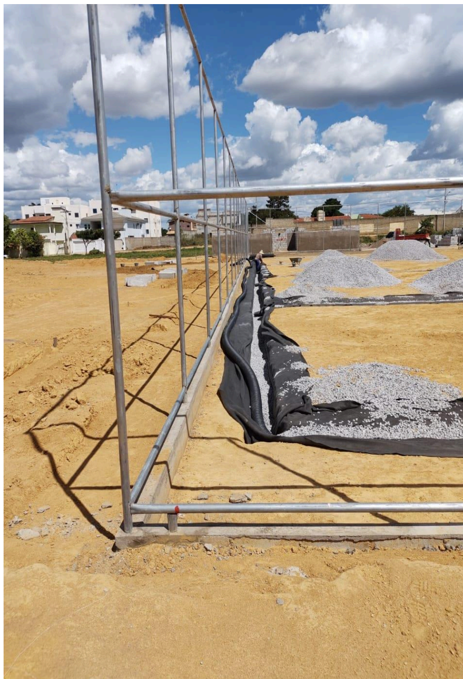
Figura 03: Execução de assentamento de tubo de drenagem sobre base de brita
