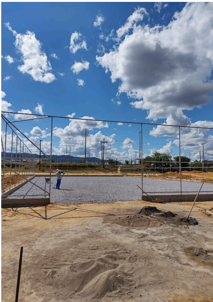
Figura 07: Execução de preparação para base
