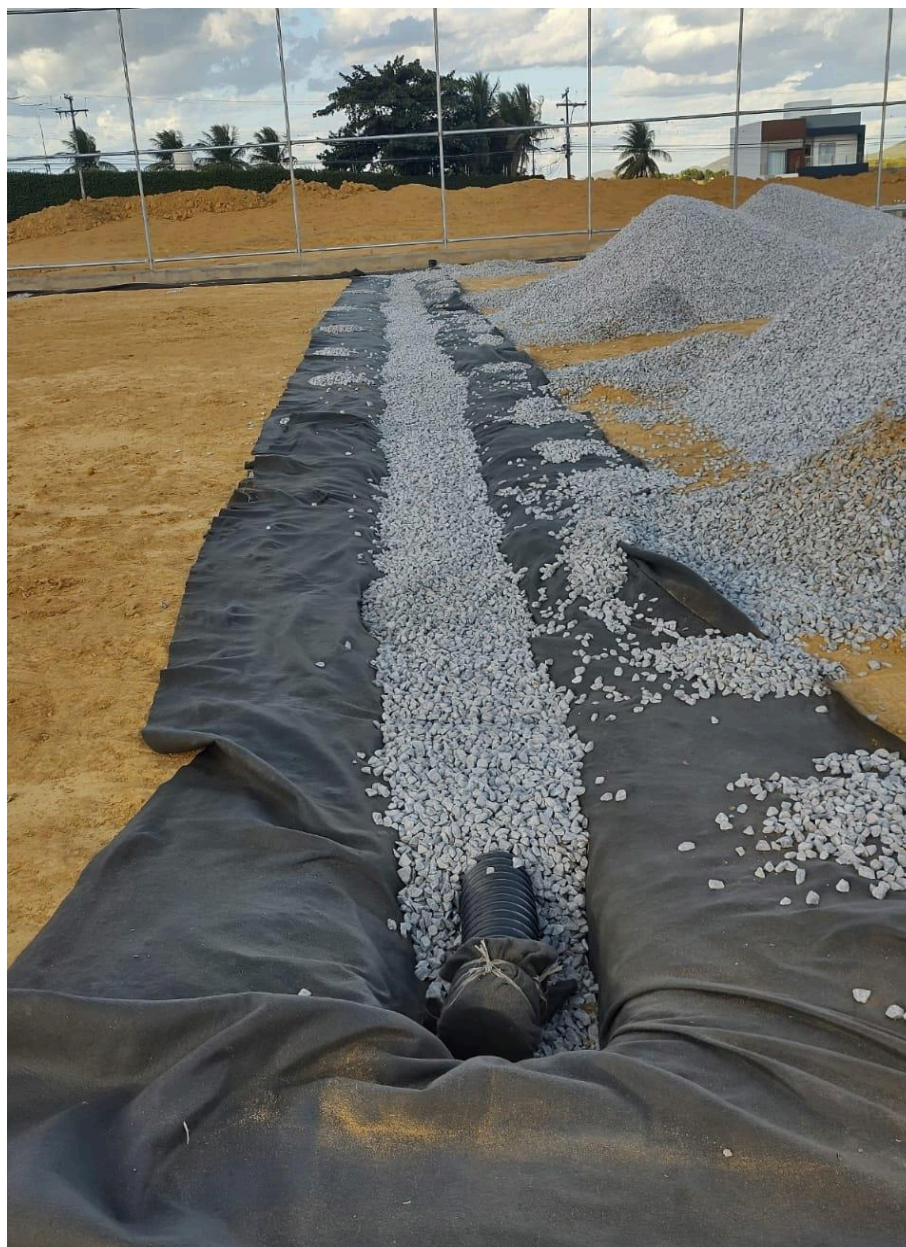
Figura 04: Execução de preenchimento de vala com brita e envelopamento de tubo de drenagem
