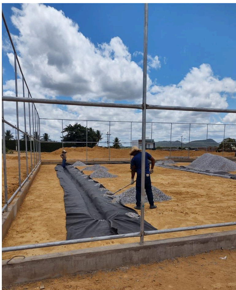
Figura 02: Execução preparação para assentamento de tubo de drenagem
