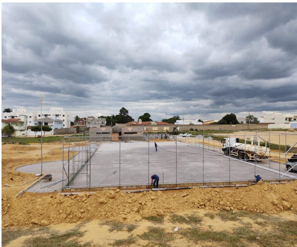
Figura 11: Base compactada e pronta para recebimento de grama
