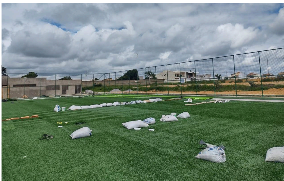
Figura 16: Espalhamento de borracha de grama sintética
