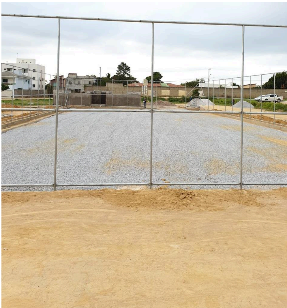
Figura 06: Execução de preparação para base
