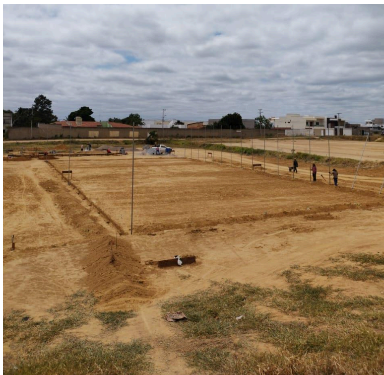
Figura 01: Execução de terraplenagem para nivelamento de recepção da base para grama.
