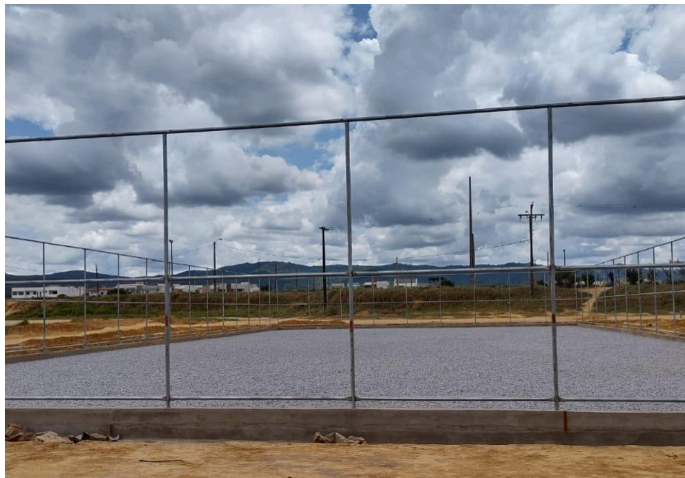
Figura 09: Execução de preparação para base
