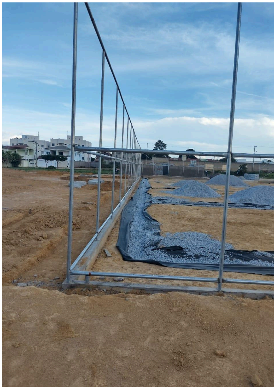
Figura 05: Execução de preenchimento de vala com brita e envelopamento de tubo de drenagem
