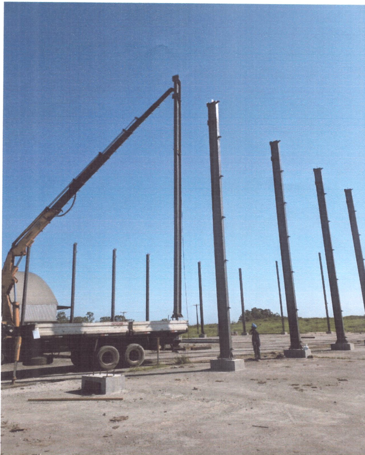
Figura 2.5: Montagem dos pilares
