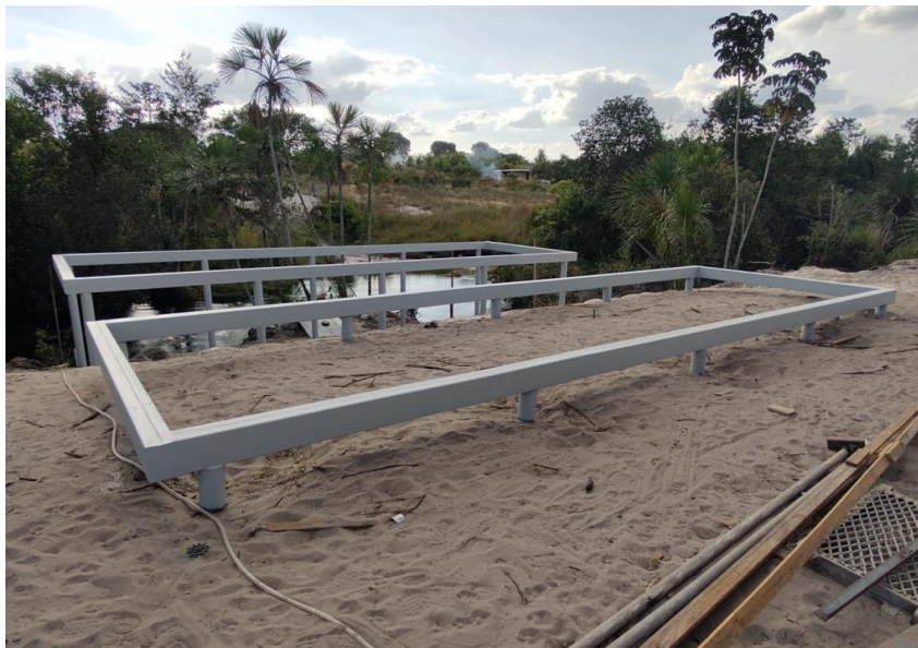
Figura 3: Estruturas de sucção para captação de água de 12 bombas
