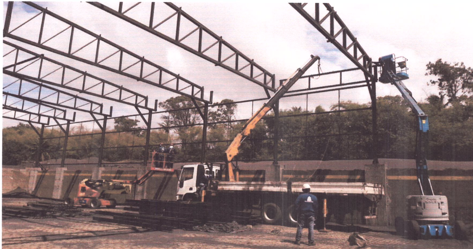
Figura 8: Montagem da platibanda
