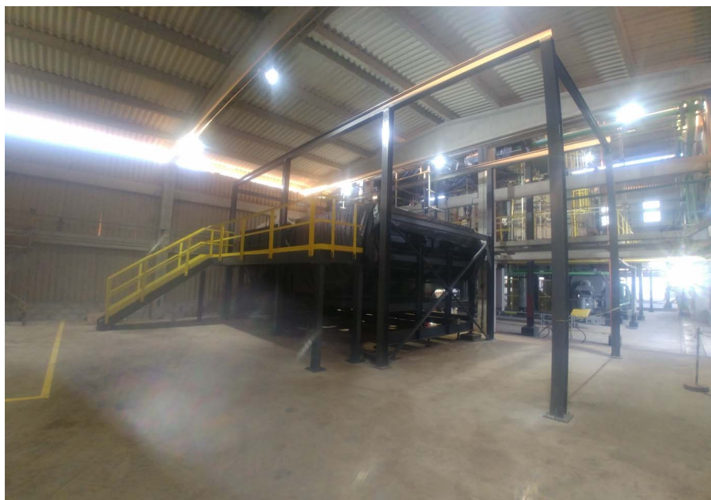
Figura 23: Estrutura para ponte rolante de 2tf e plataforma e escada para acesso a moega
