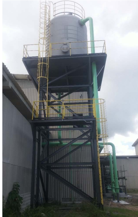
Figura 6: Perspectiva da estrutura projetada e executada – Torre Head Tank
