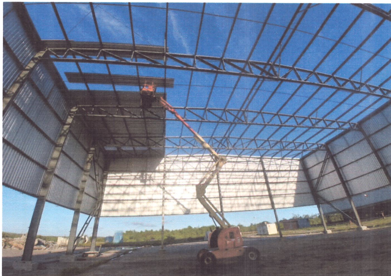
Figura 2.7: Instalação das telhas de cobertura
