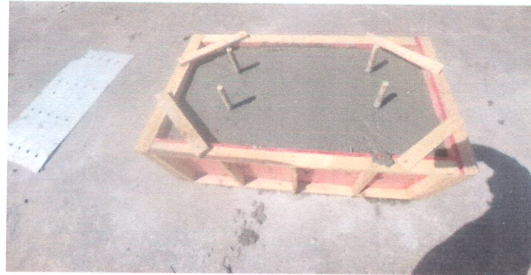
Figura 2.4: Visão geral das armações, fôrmas e concretagem das bases
