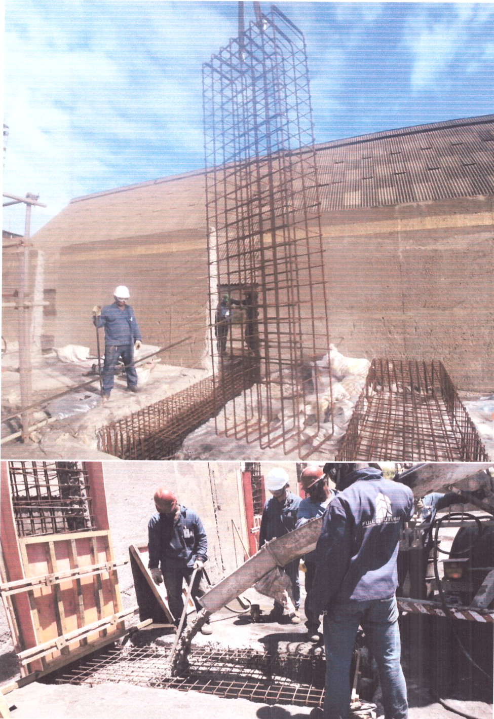
Figura 4: Armação, fôrma e concretagem da fundação
