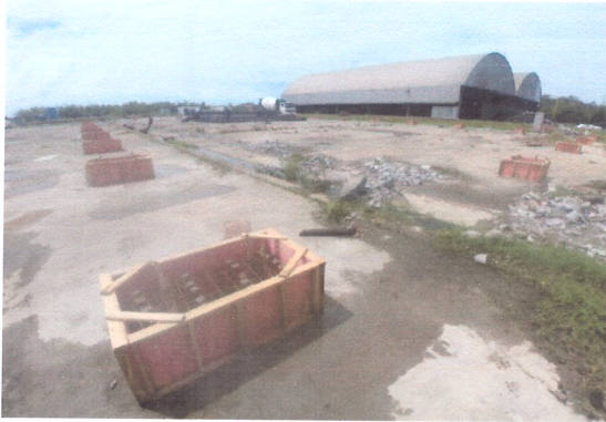
Figura 2.4: Visão geral das armações, fôrmas e concretagem das bases
