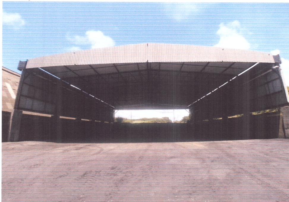
Figura 14: Vista frontal do galpão
