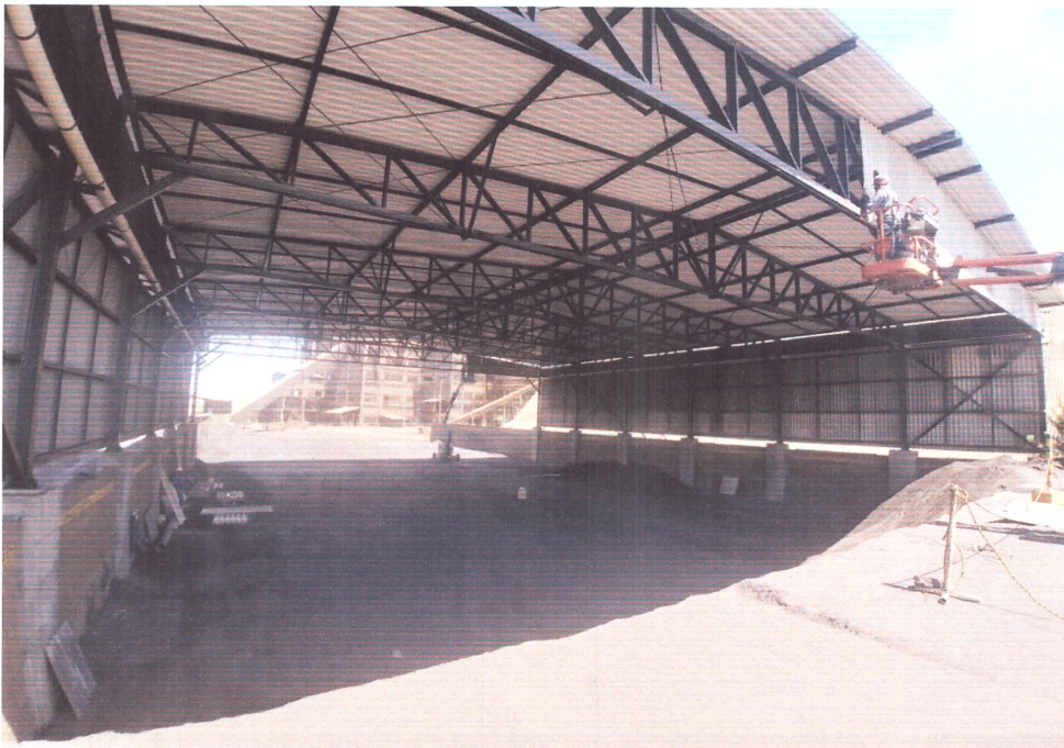
Figura 12: Montagem das telhas de fechamento do fundo em fibrocimento ondulado de 8mm
