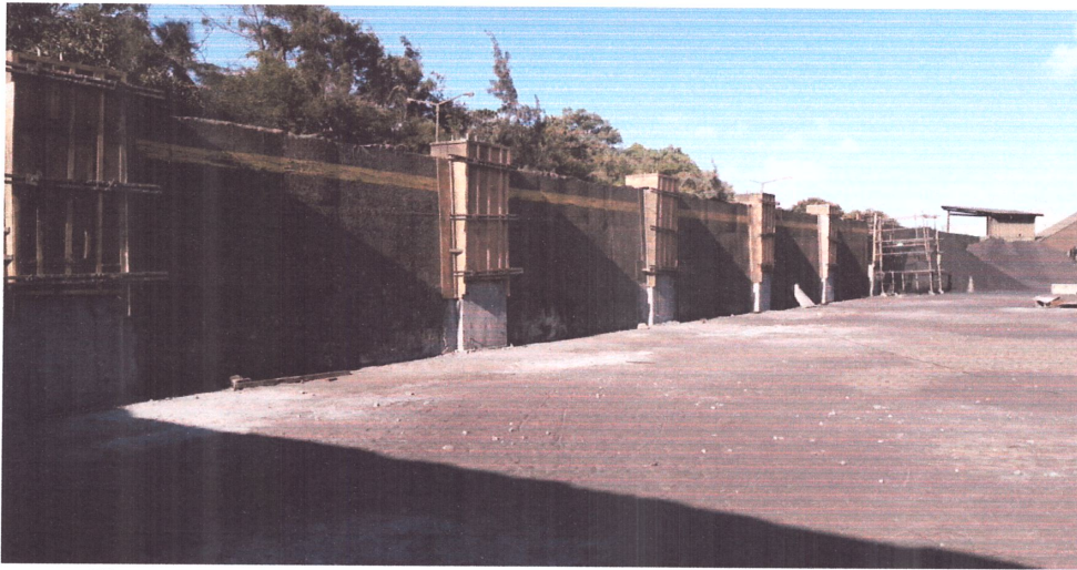
Figura 5: Formas para concretagem dos últimos tramos dos pilares de concreto
