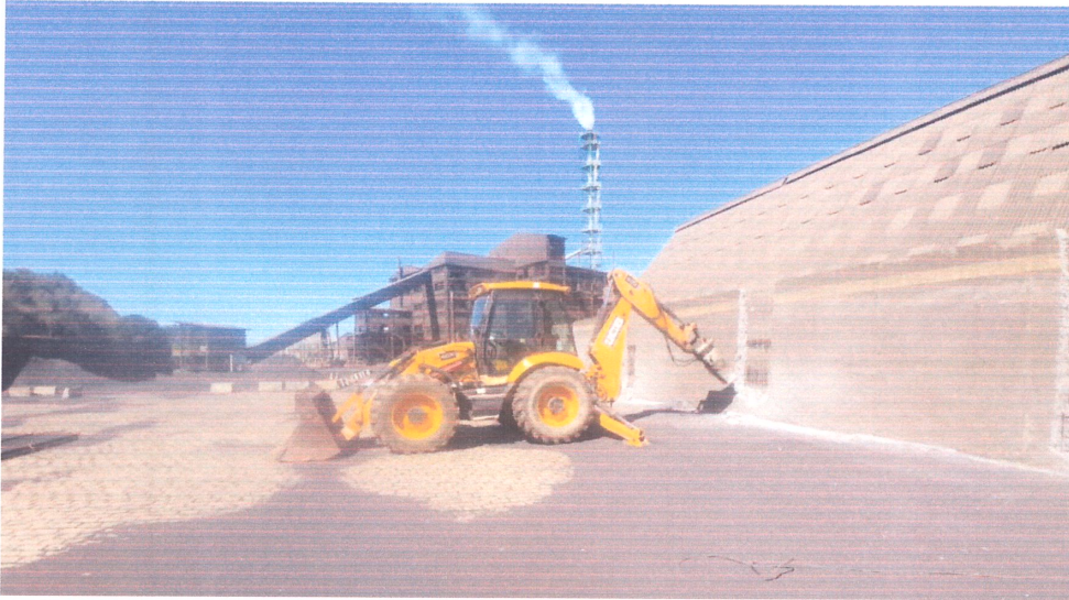
Figura 2: Demolição de paredes
