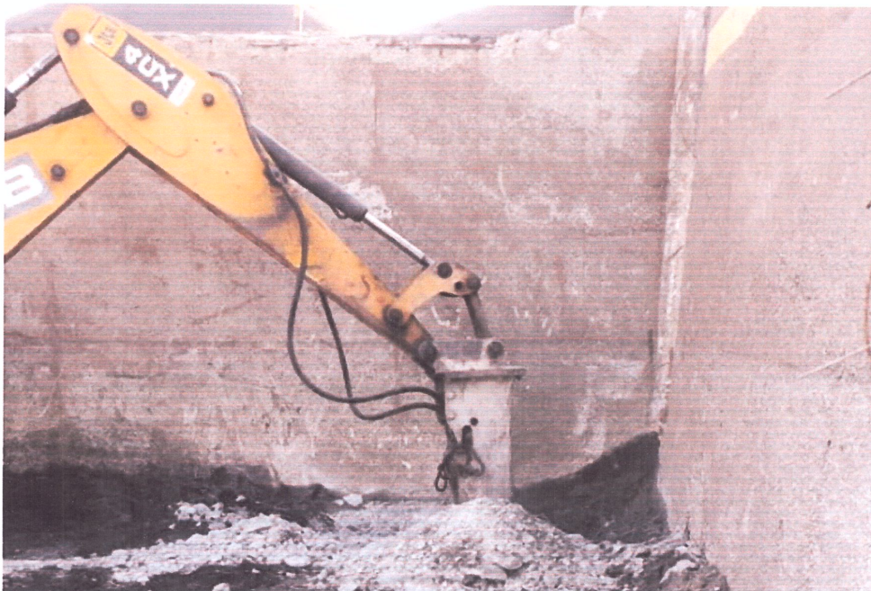
Figura 3: Demolição de piso
