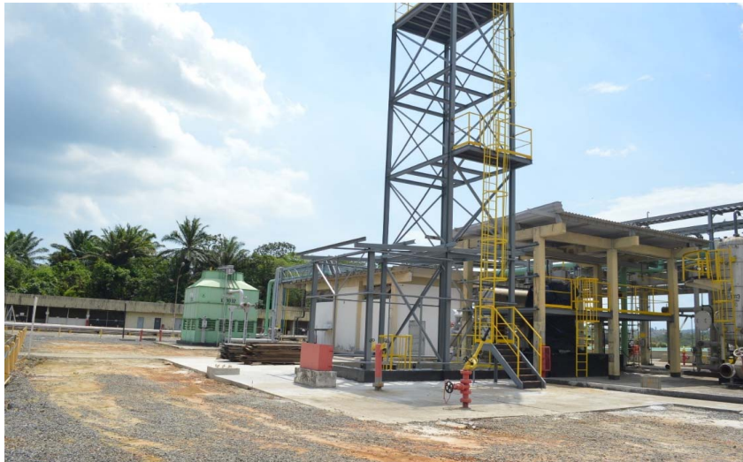
Figura 9: Estrutura da torre termal e plataforma 8x4 (dentro do galpão pré-moldado)
