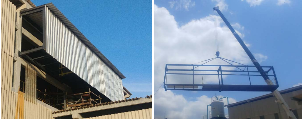
Figura 24: Plataforma e cobertura da moega
