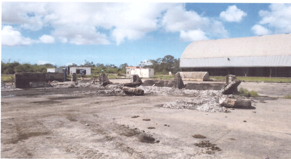
Figura 2.3: Visão geral das demolições (em andamento)
