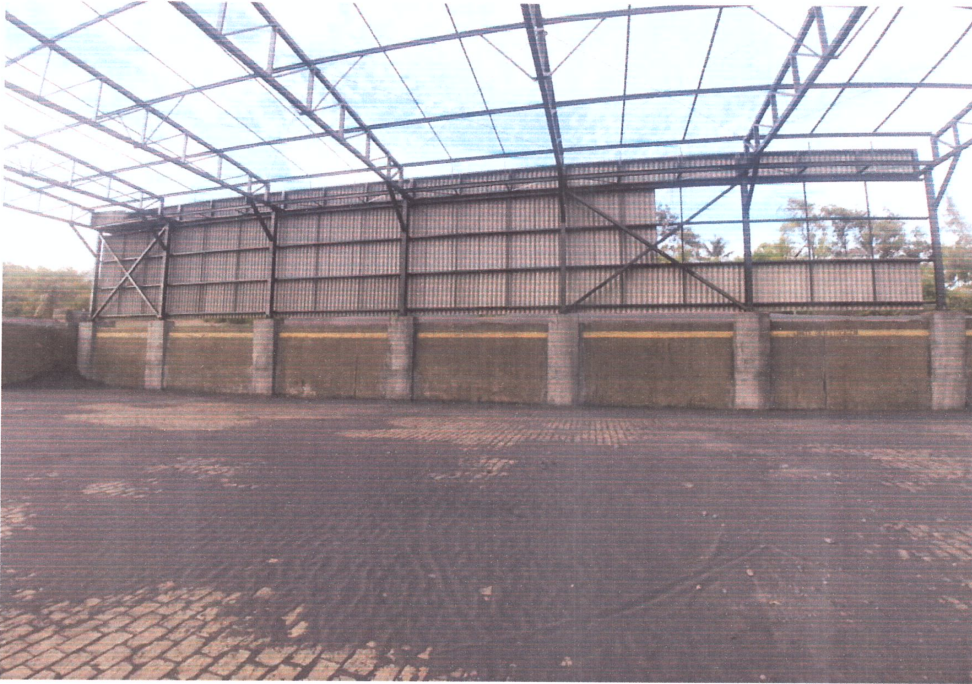
Figura 11: Montagem das telhas de fechamento lateral em fibrocimento ondulado de 8mm
