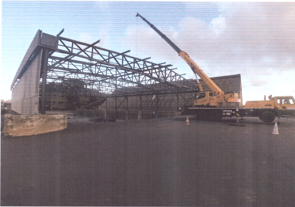
Figura 9: Lçamento das telhas metálicas da cobertura
