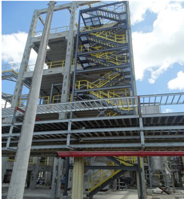
Figura 12: Escada metálica com 10 lances (EL100,100 a EL120,100)
