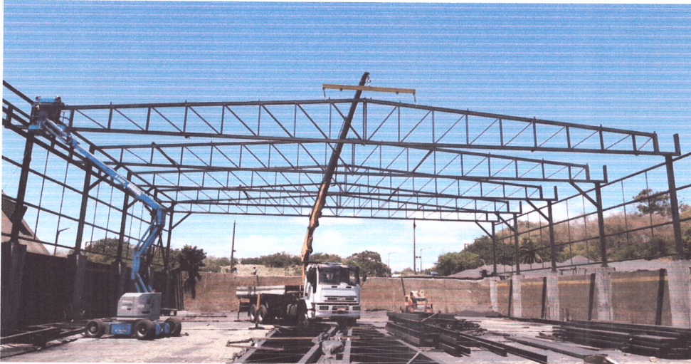
Figura 7: Montagem das treliças
