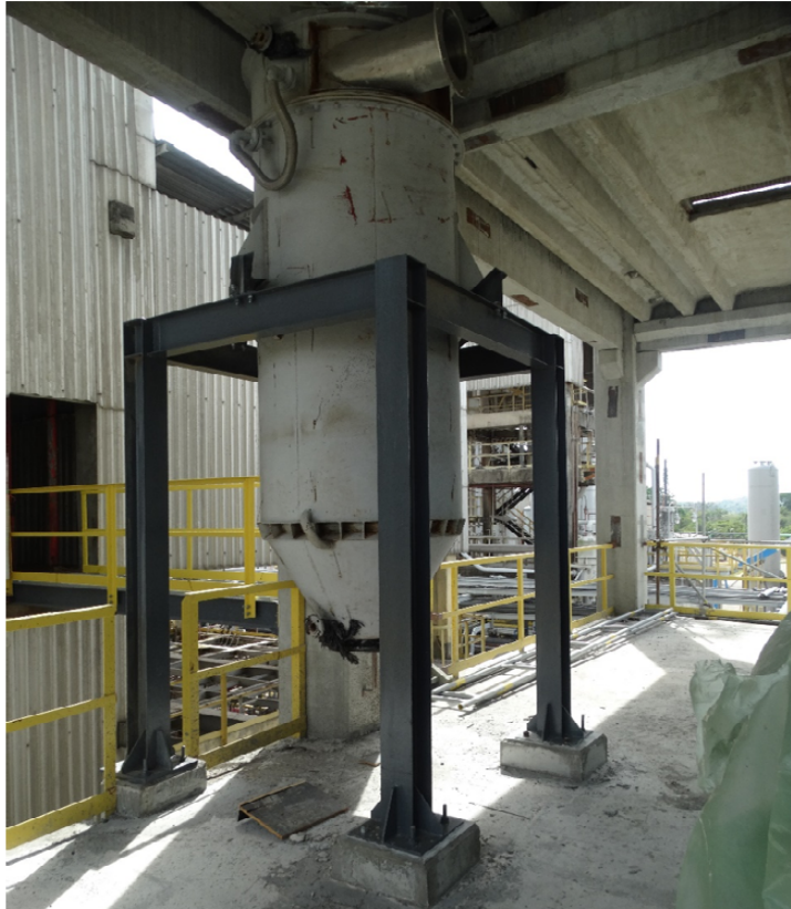
Figura 16: Estrutura para apoio do Y-4426A
