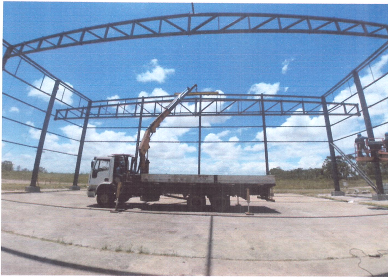
Figura 2.6: Montagem das treliças
