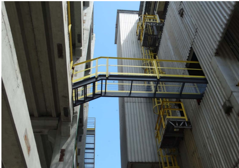
Figura 15: Passarela de acesso a EL110,050 entre dois prédios
