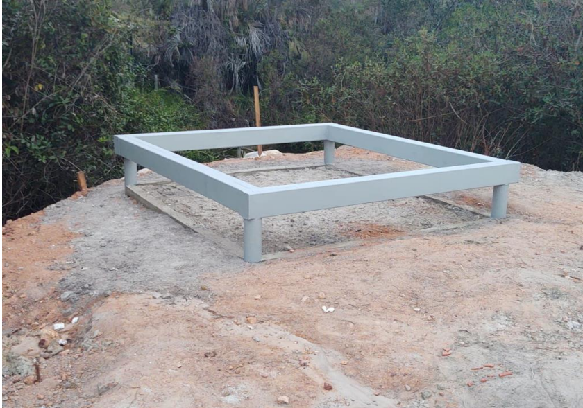
Figura 4: Estruturas de sucção para captação de água de 2 bombas
