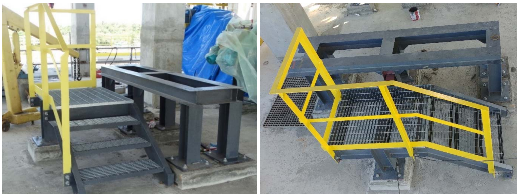
Figura 17: Estrutura para suporte E-4400A
