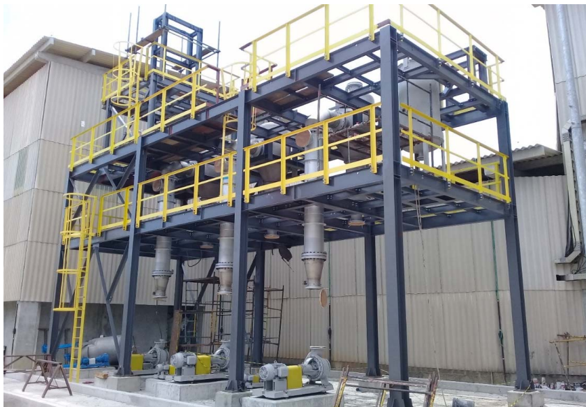
Figura 11: Estrutura do Prédio da Evaporação
