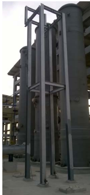
Figura 7: Perspectiva da estrutura projetada e executada – Trocador de Calor
