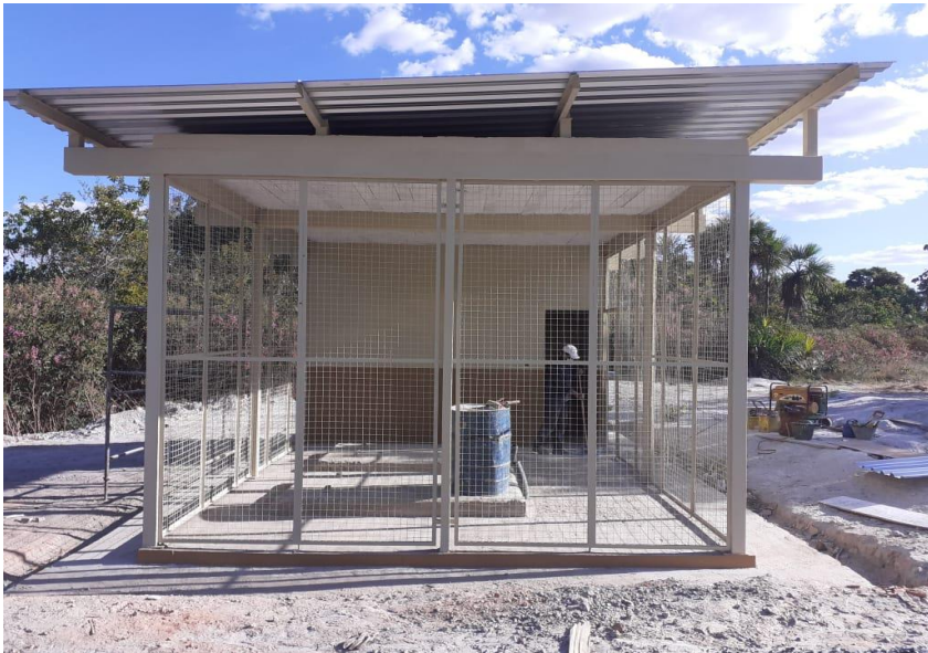
Figura 9: Casa de bombas para 2 motores
