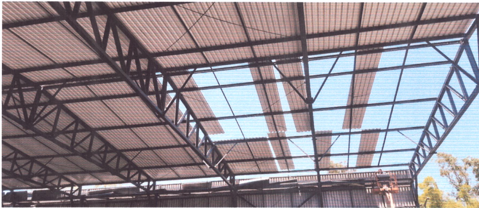
Figura 10: Montagem das telhas metálicas da cobertura
