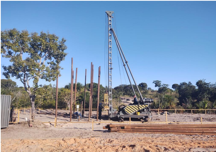
Figura 5: Cravação de estacas metálicas com bate estaca de queda livre
