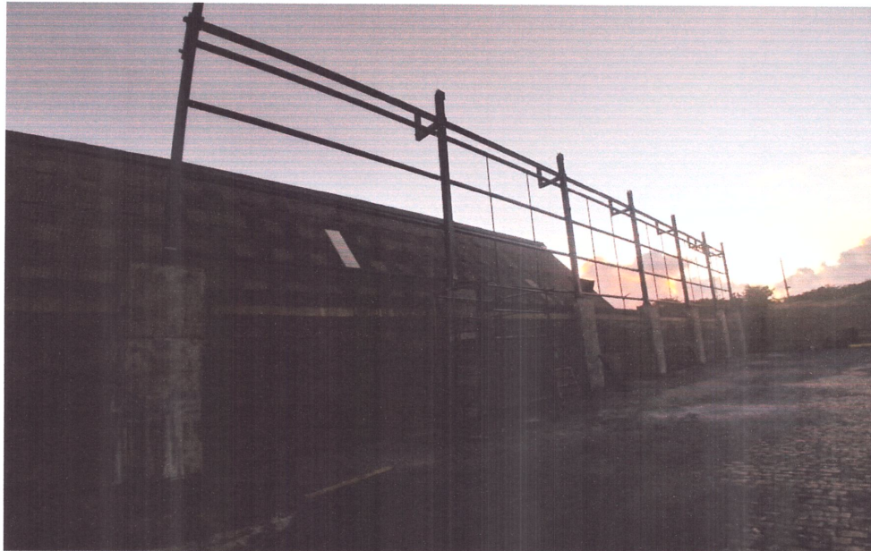
Figura 6: Pilares de concreto finalizados, montagem dos pilares e terças
